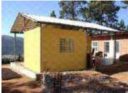
**Fig. 10a** : Logement expérimental construit en 2009 au Brésil avec des panneaux à base de PG.
