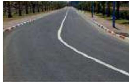
**Fig. 10b** : Tronçon expérimental de route au Maroc construit en 2019 (longueur 200 m avec 65% de PG).
