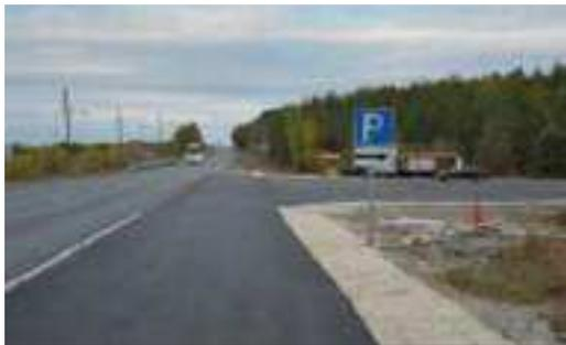
**Fig. 9b** : Vue d'un tronçon de route construit à base de PG / Russie [4].
