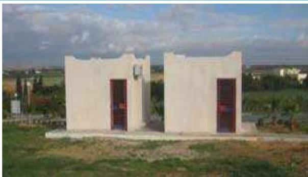
**Fig. 12a** : Chambres construites avec matériaux conventionnels (à droite) et avec des briques contenant 25% de PG (à gauche).
